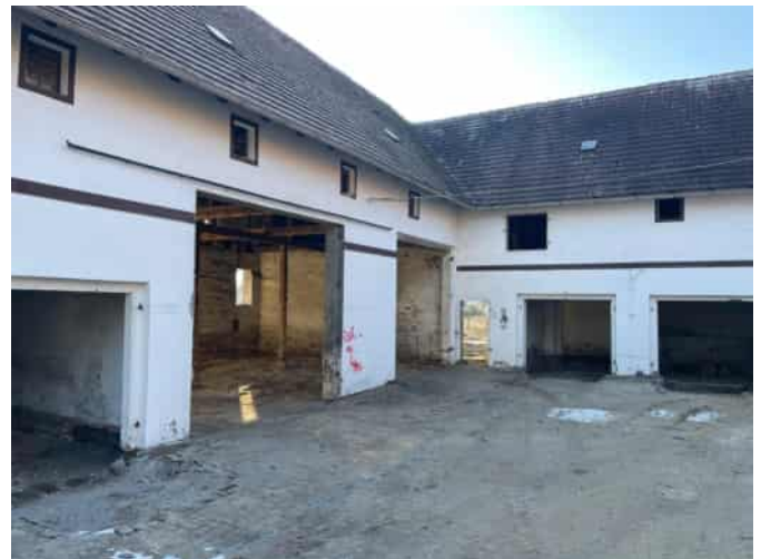
Die Bauarbeiten am neuen Wirtschaftshof für den Zoo Hoyerswerda laufen seit Herbst 2025. Der Verein der Zoofreunde unterstützt das Projekt mit 50.000 Euro. (Foto: Bruins)
