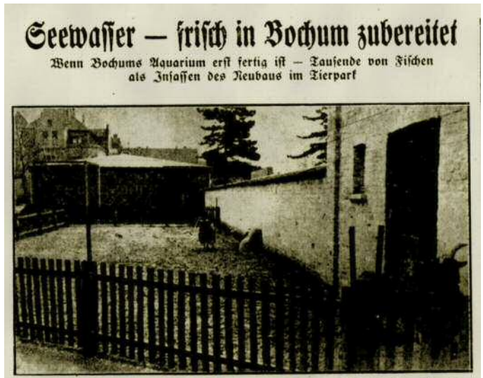
In den Bochumer Nachrichten wurde am 09. März 1939 detailliert über die Bauarbeiten des neuentstehenden Aquariums berichtet. Das Gebäude war zu dem Zeitpunkt schon fertiggestellt und der Ausbau des Innenbereiches im Gange. (Foto©TPBO_Aquarium_Tierpark_Rohbau)
