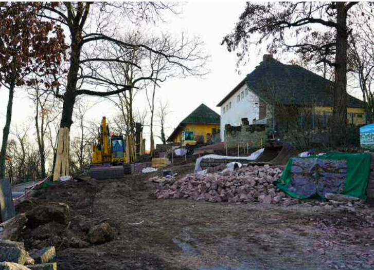
Baustelle Reilsalm (Foto: Dr. D. Müller)
