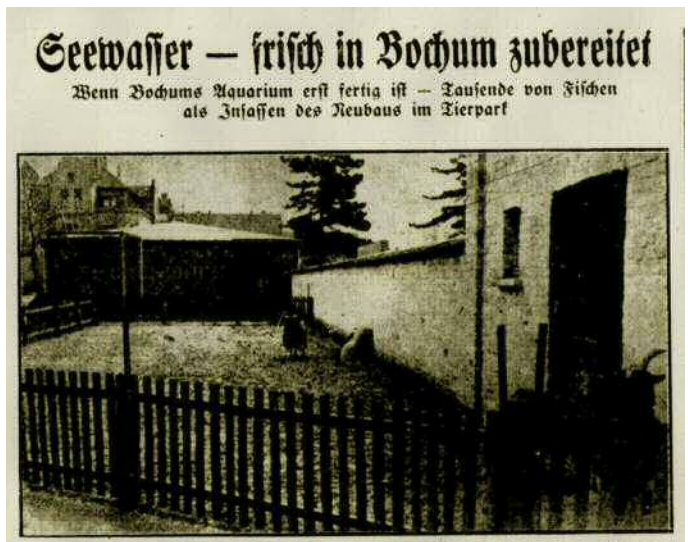
In den Bochumer Nachrichten wurde am 09. März 1939 detailliert über die Bauarbeiten des neuentstehenden Aquariums berichtet. Das Gebäude war zu dem Zeitpunkt schon fertiggestellt und der Ausbau des Innenbereiches im Gange. (Foto©TPBO_Aquarium_Tierpark_Rohbau)
