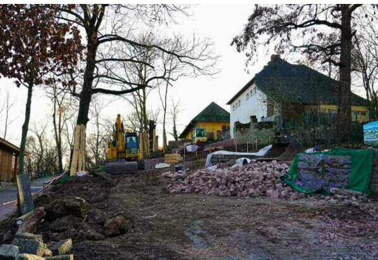
Baustelle Reilsalm (Foto: Dr. D. Müller)
